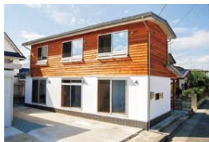
改修後住宅外観
