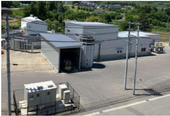
バイオガスプラント 外観
