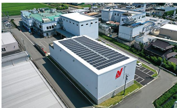
冷凍倉庫に太陽光パネルの設置
