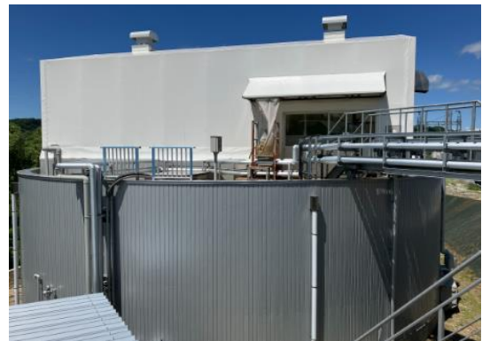
発酵槽（下部 円筒型）で発生したガスを上部のガスバッグ室にて貯留し、発電機へ供給する。
