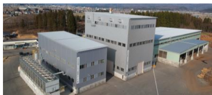
もがみ木質バイオマス発電所
