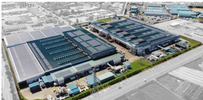
工場屋根に設置するメガソーラー発電設備
