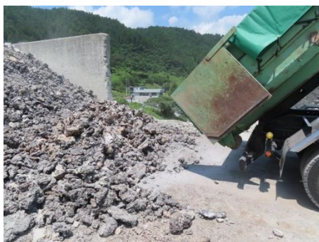
鉍滓を路盤材としてリサイクル
