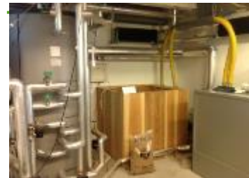
↑ オーストリア製のペレットボイラー (右) と、ペレット燃料を入れるサイロ (真ん中) と蓄熱槽 (左)。家庭用ペレットボイラーとしては全国で初の導入。
